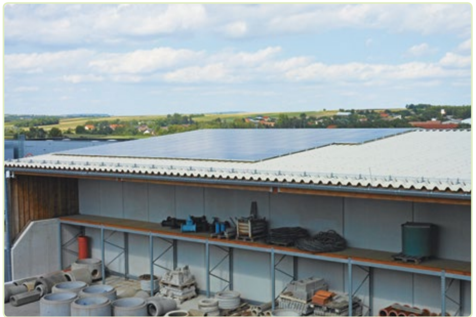
Neue Photovoltaikanlage am Dach des ASZ Altstoffsammelzentrum.
