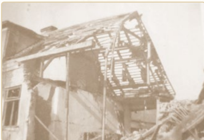
So sahen die Häuser nach den Bombenangriffen aus.
