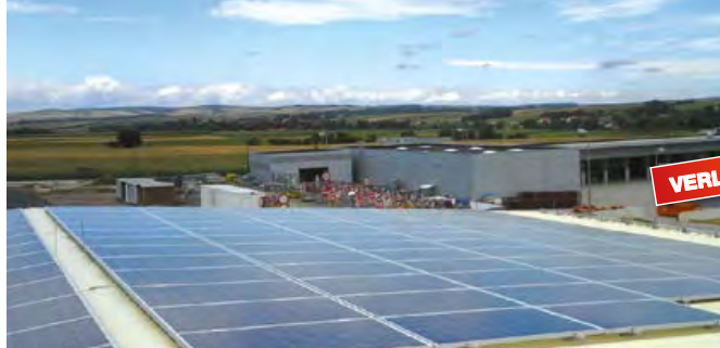
276 Photovoltaik-Panels auf dem Sierndorfer Altstoffsammelzentrum und der Kläranlage sorgen bereits für umweltfreundlichen Sonnenstrom
