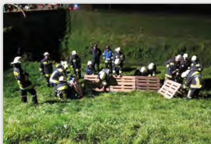
Aufbau des provisorischen Damms mit Europaletten.
