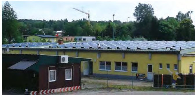
Ein sportlicher Erfolg für die nachhaltige Energieerzeugung: 30kWp-Photovoltaik-Anlage am Sportplatzgebäude Sierndorf
