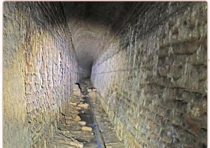
Teilansicht des 1928 gegrabenen, über 100 m langen Sickerschachtes der WVA Untermallebarn.
