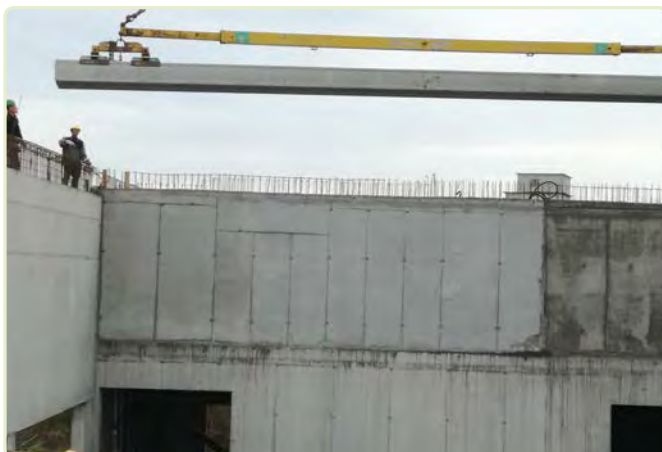
Die Decke des neuen Turnsaales bei der Montage ...
