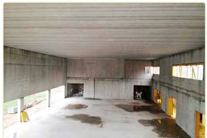
... und nach erfolgter Verlegung der Fertigteile.
