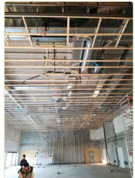
Das neue Blechdach und die Vorbereitungen für die Decke im neuen Turnsaal.
