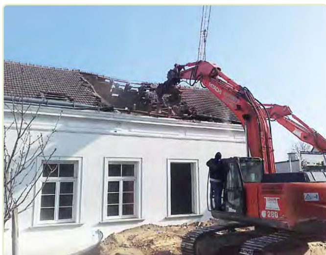
Zwei Bagger sortieren und demontierten unsere alte Schule.
