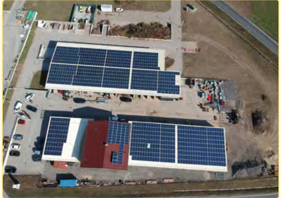
Luftaufnahme der Photovoltaikanlagen am Bauhof und Altstoffsammelzentrum.
