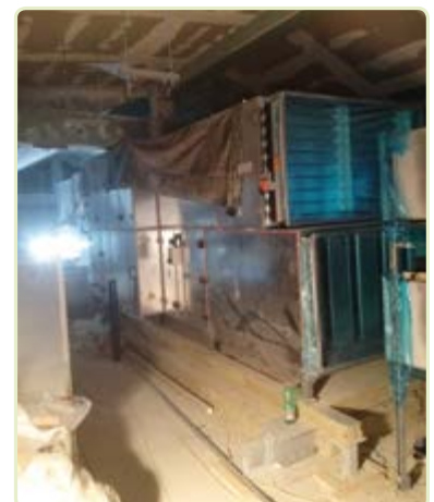
die Zentrale des Lüftungsystems.
