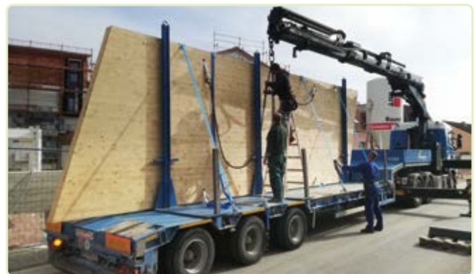
... das Dach für den Fahrrad Unterstellplatz sowie ...
