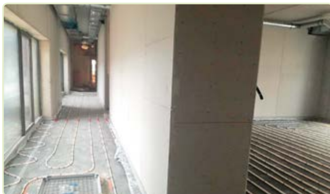
... die Fußbodenheizung, ...
