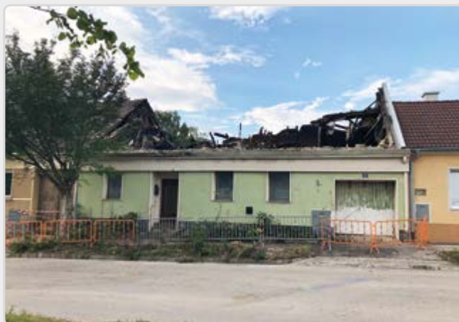
Die Brandruine nach dem Ende des Einsatzes.
