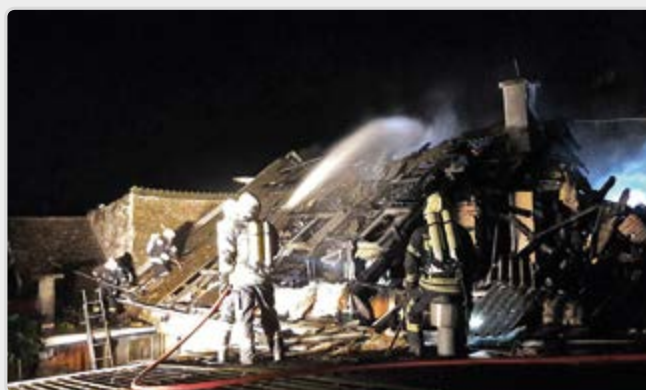
Die Atemschutztrupps legten das Dach frei, um an die Glutnester zu kommen.
