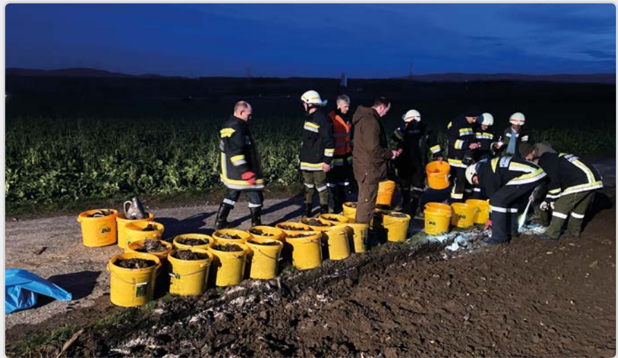
Das kontaminierte Erdreich wird abgetragen und entsorgt.
