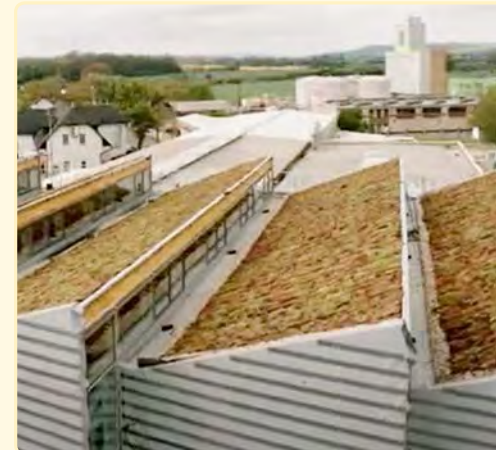
Intensives Gründach aus Systemelementen.
