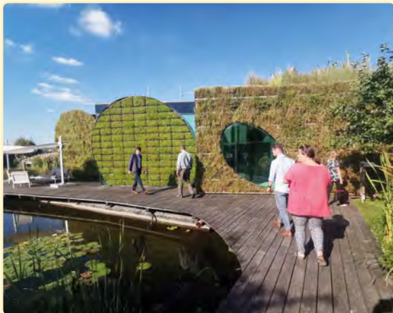
Begrünung von Fassaden und Gebäuden.
